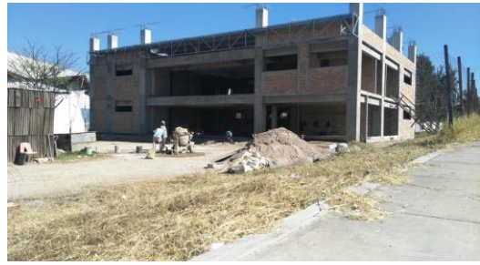
F1: Fachada principal
