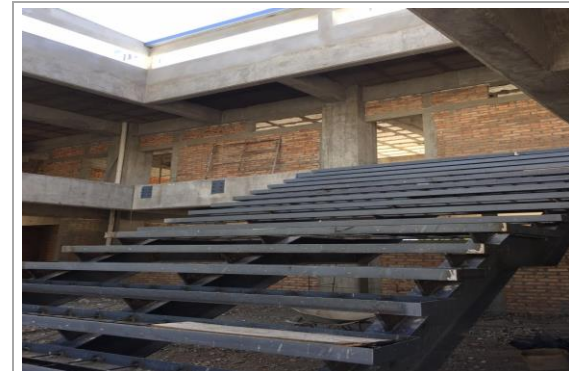
F5: Interior de aula
