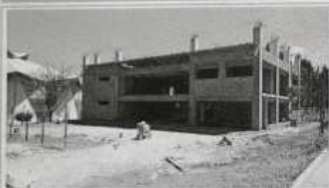
F1 Fachada exterior
