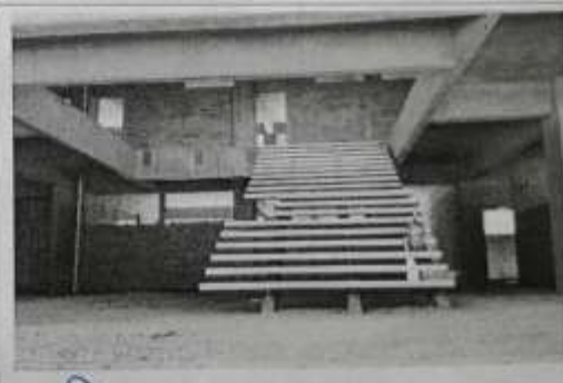
F5 Escalera de acceso
